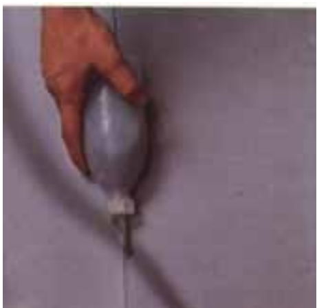
Συμπληρωματική σφράγιση των ραφών με ρευστό PVC
