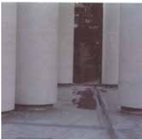
Απόληξη μεμβράνης σε στρογγυλό υποστήλωμα
