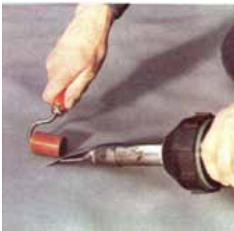
Συγκόλληση με θερμό αέρα (βουλκανισμό)
