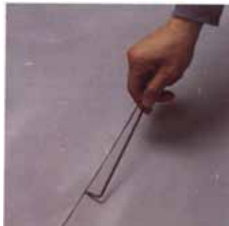
Ελεγχος της συγκόλλησης των ραφών με ειδικό εργαλείο
